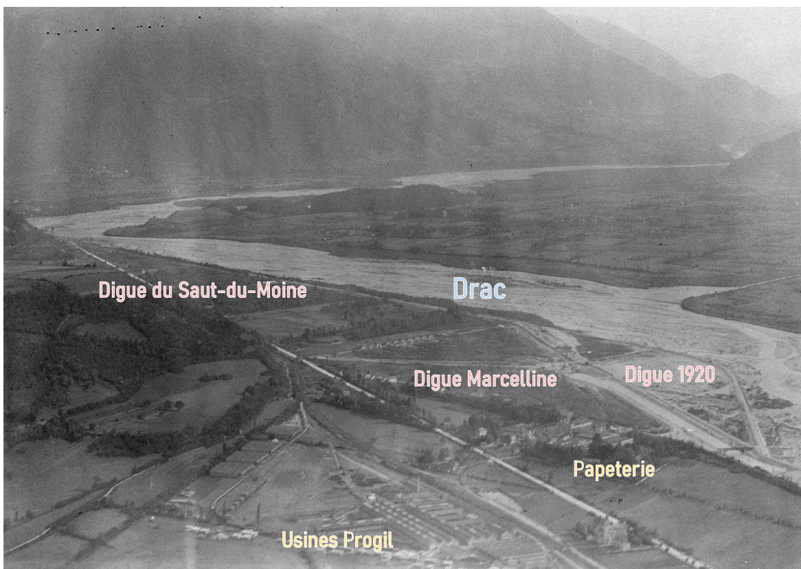
7. Bassin du Drac modifié lors de la construction de la centrale Drac Romanche, 1920
