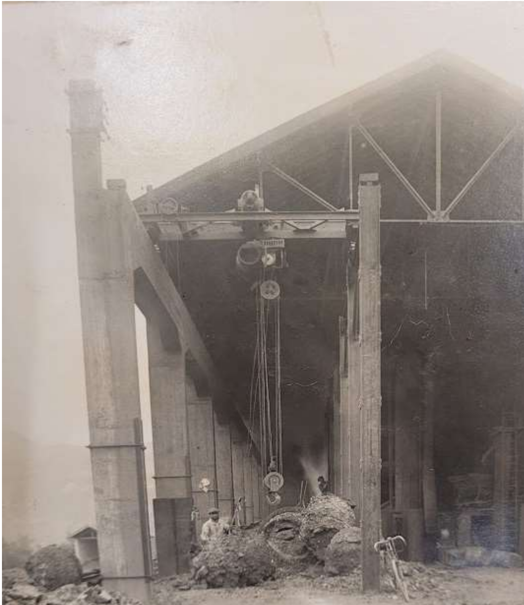
8. Halle de l'Achromine à Pont-de-Claix, 1929
