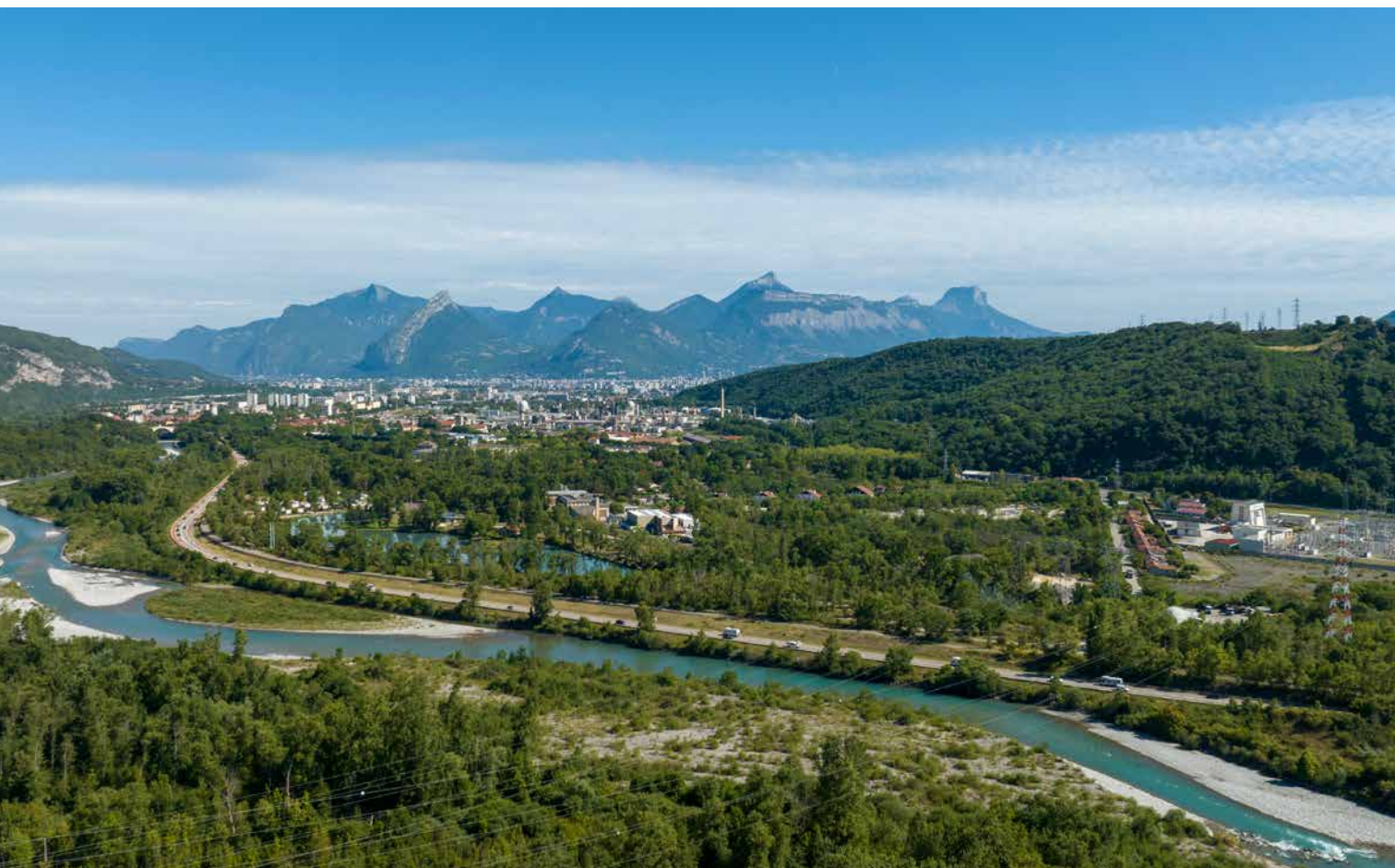
Vue aérienne du site de la Houille Blanche
