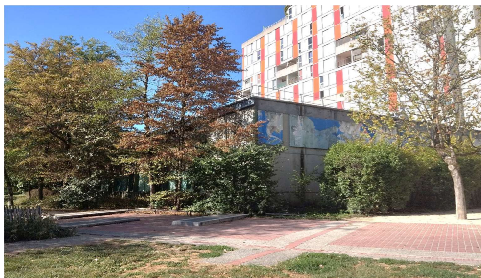
Centre sportif de la Rampe, façade Est, avant travaux
