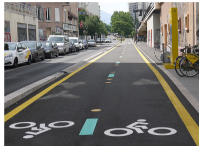
UNE DOUBLE VOIE CYCLABLE SÉPARÉE DE LA CHAUSSÉE ET DU TROTTOIR, pour pouvoir pédaler en sécurité
