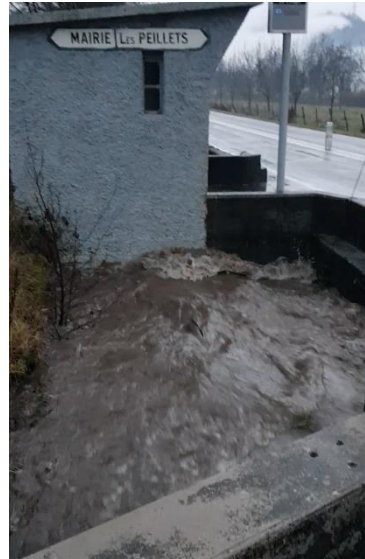
PRÉMOL, PONT DE LA MAIRIE, DÉCEMBRE 2021
