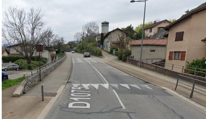
Vue de l'existant - rampe
