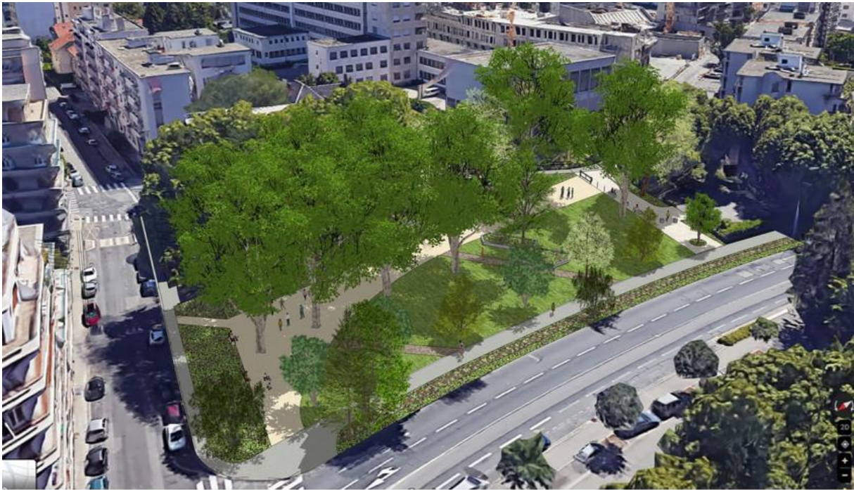
Vue aérienne du futur parc situé en lieu et place du parking au 51 rue Mallifaud à Grenoble. © Ville de Grenoble
