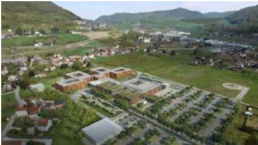
Nouvel hôpital de Voiron (septembre 2021)
